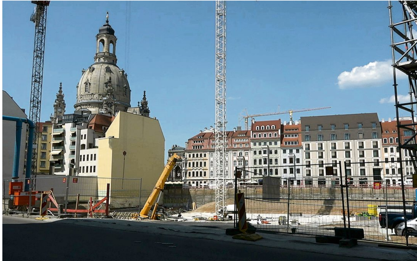
Bloß keine zeitgenössische Architektur?! Jede Baulücke im Dresdner Stadtzentrum weckt bei vielen die Sehnsucht, dass dort etwas Vertrautes entstehen möge.
